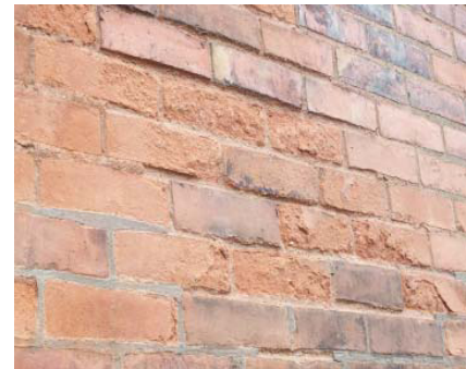
Spalling
